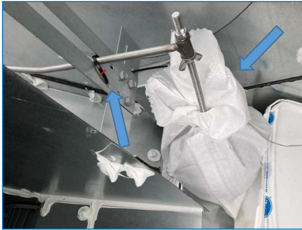
Fastsättning och lindning av flottörkula
