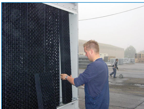
Demontering av kombinerade inloppspaneler
