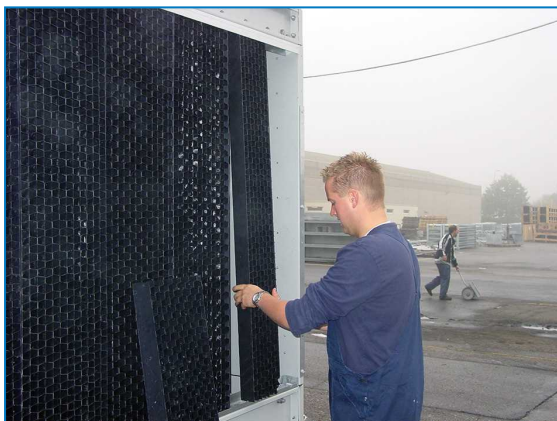
Demontering av kombinerade inloppspaneler
