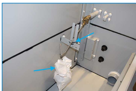
Fastsättning och lindning av flottörkula
