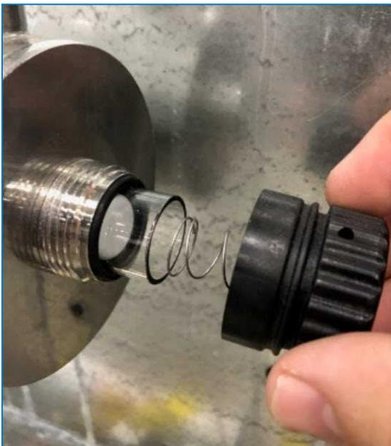
Entfernen des UV-Quarzhüllrohrs
