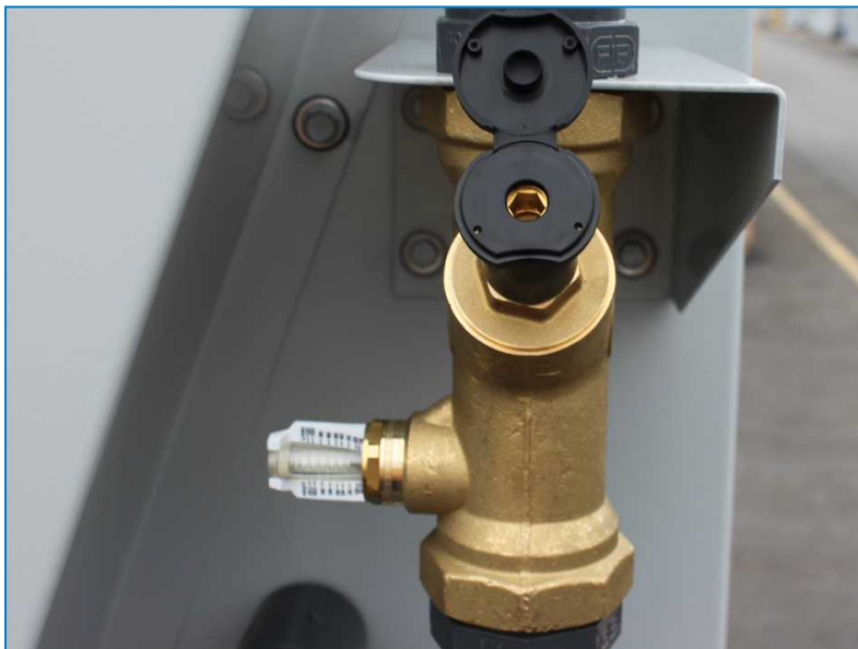
Einstellschraube für den Wasserfluss
